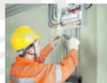
d) Lắp đặt mạng điện trong nhà
