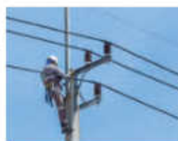
d) thợ lắp đặt và sửa chữa đường dây điện
