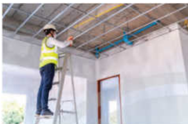
Hình 7.1. thợ lắp điện cho toà nhà
