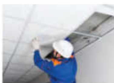
c) thợ lắp điện cho toà nhà
