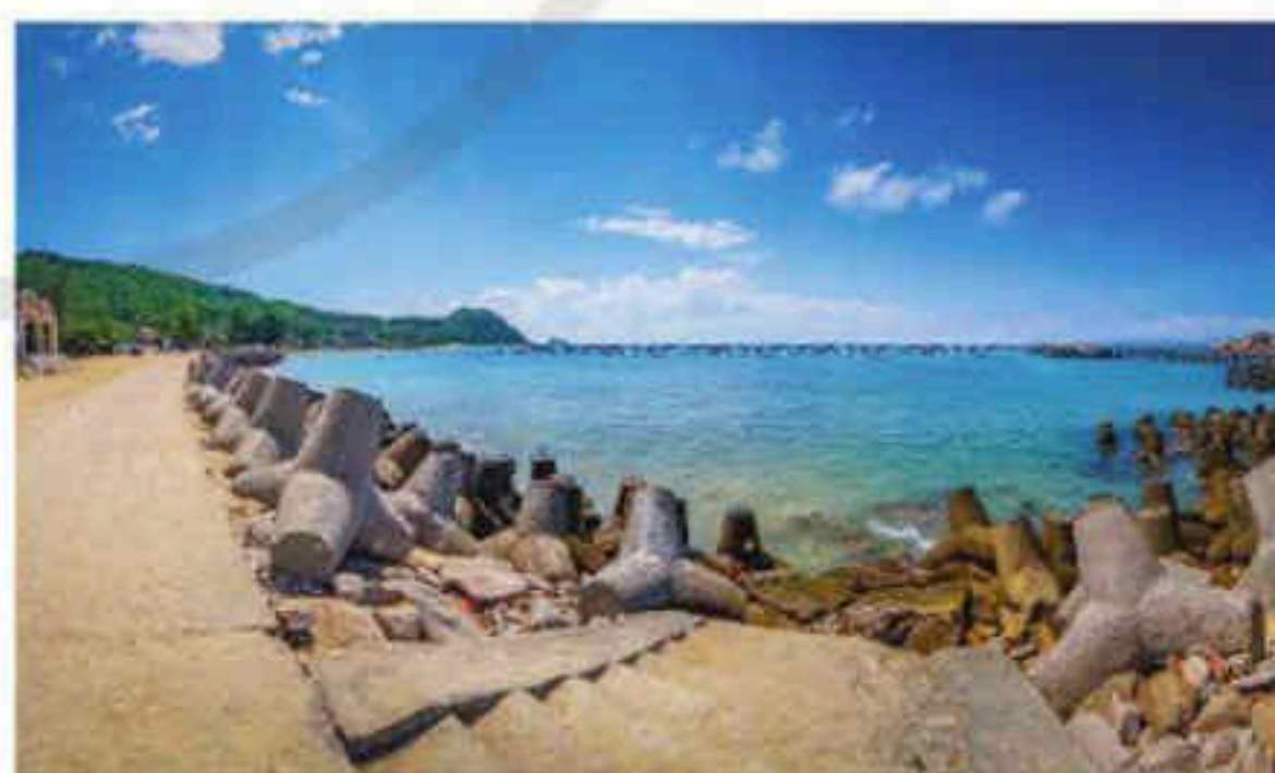
Hình 2.6. Một đoạn đê biển trên đảo Cù Lao Xanh (thành phố Quy Nhơn, tỉnh Bình Định)
