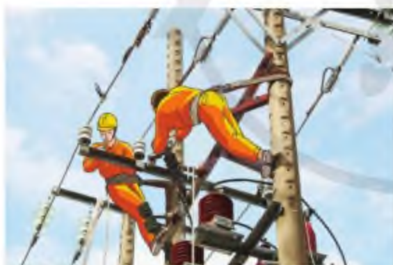
a) Sửa chữa đường dây điện
