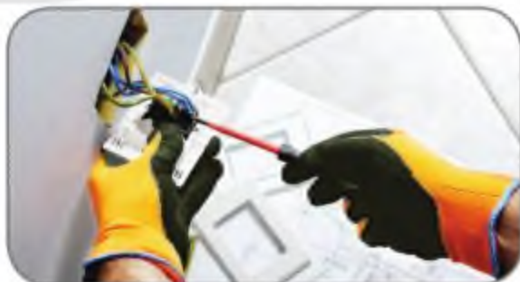
Hình 11.2. Sửa chữa mạch điện
