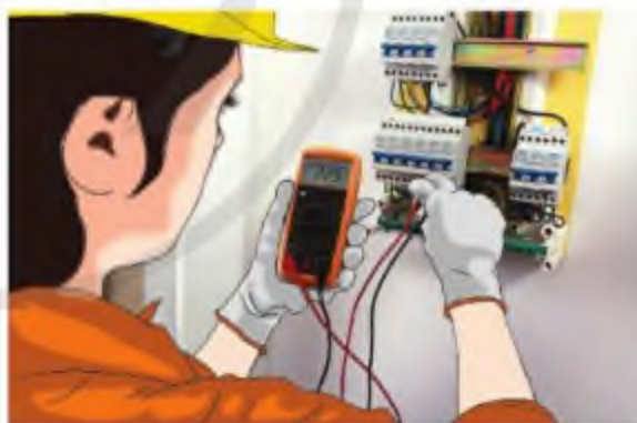
b) Kiểm tra tủ điện
