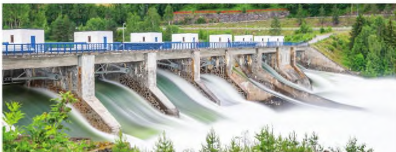
Hình 12.5. Nhà máy thủy điện
