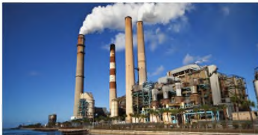
Hình 12.6. Nhà máy nhiệt điện
