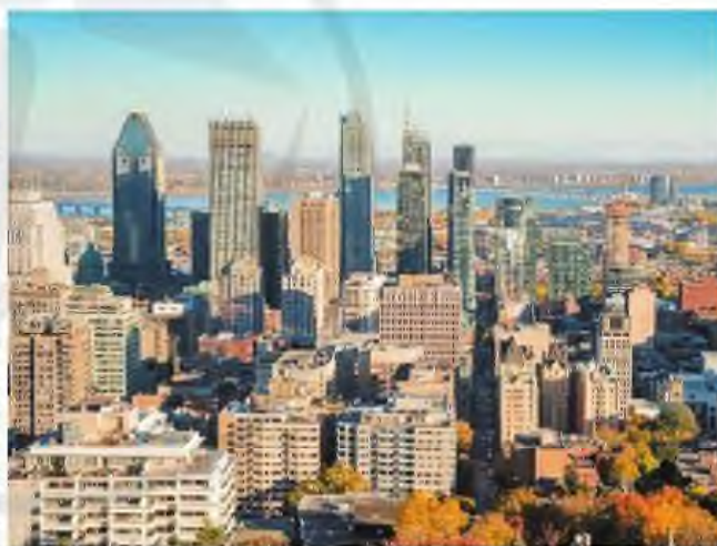
Hình 16.4. Thành phố Môn-trê-an (Ca-na-đa)
