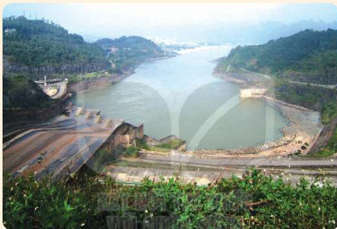
a) Đập thủy điện
