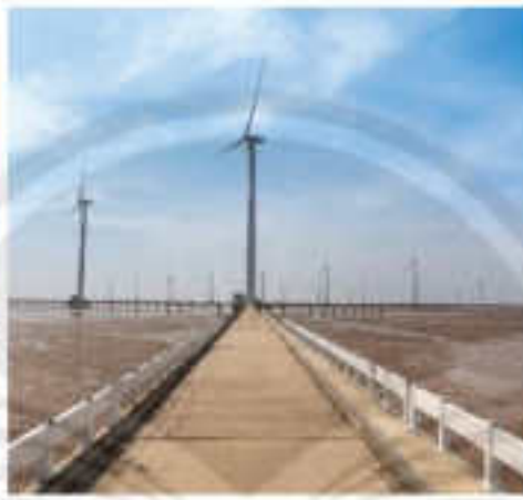
b) Trạm phát điện gió (Bạc Liêu)
