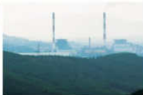
▲ Hình 10.8. Nhà máy nhiệt điện
