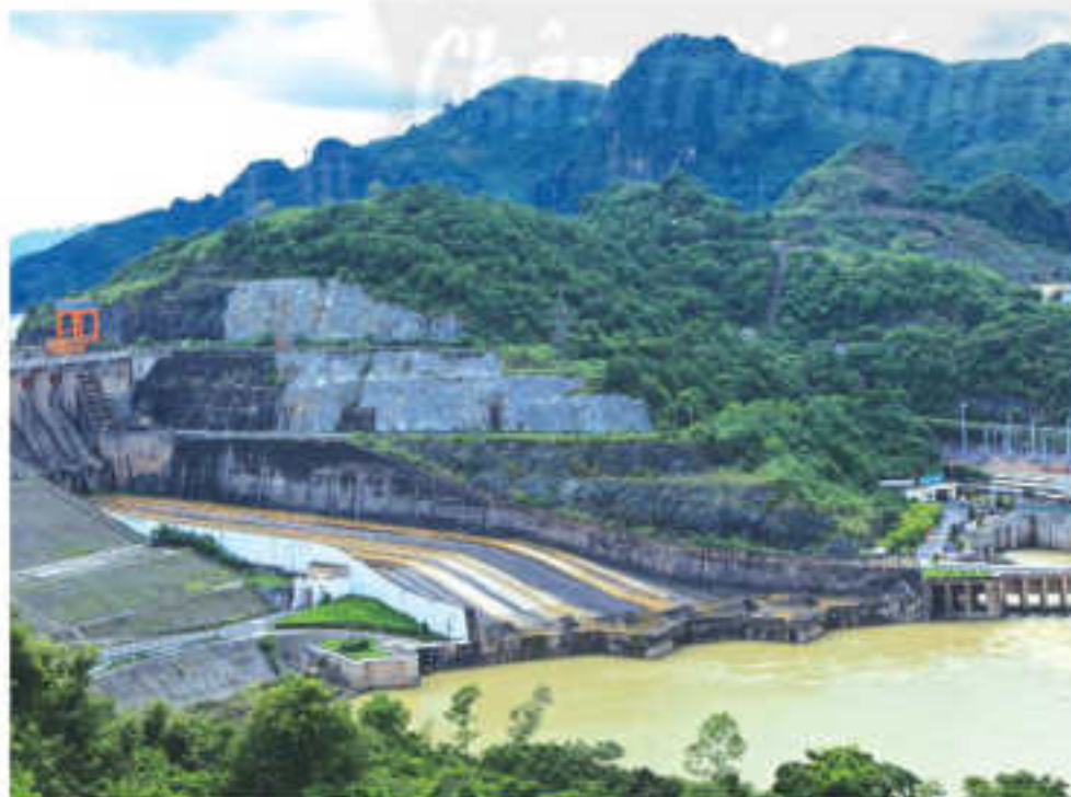
c) Nhà máy thủy điện (Hoà Bình)
