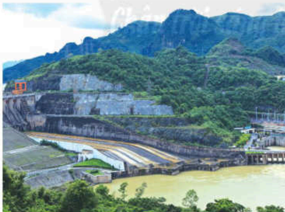
c) Nhà máy thủy điện (Hoà Bình)
