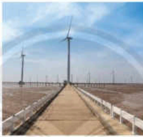
b) Trạm phát điện gió (Bạc Liêu)
