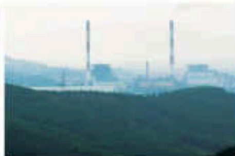
▲ Hình 10.8. Nhà máy nhiệt điện
