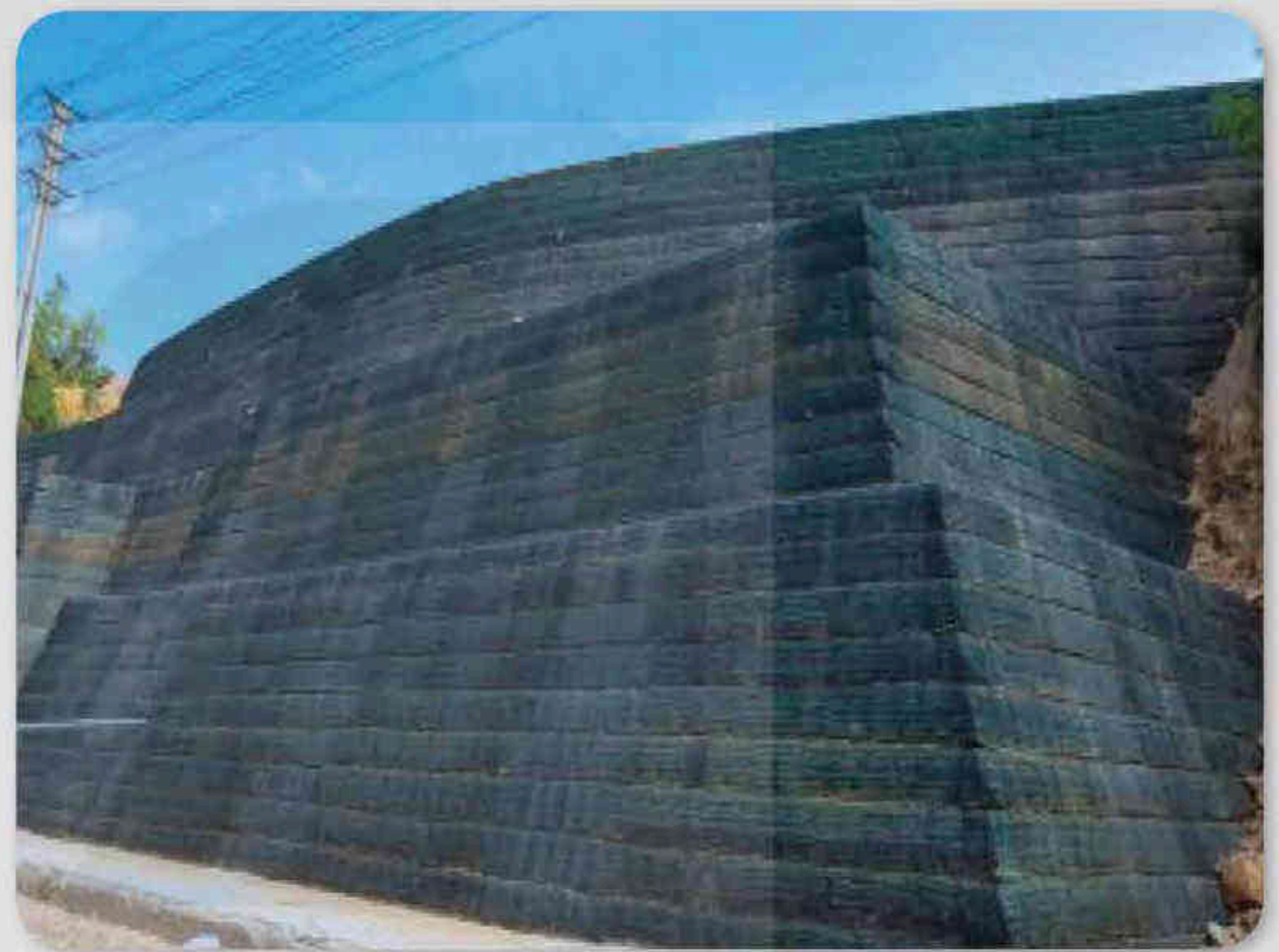
c) Xây bờ kè
