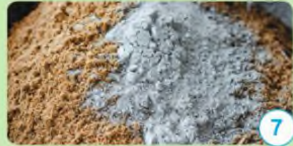
Xi măng và cát khô được trộn với nhau
