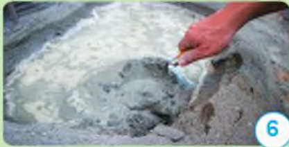
Xi măng, cát và nước được trộn với nhau
