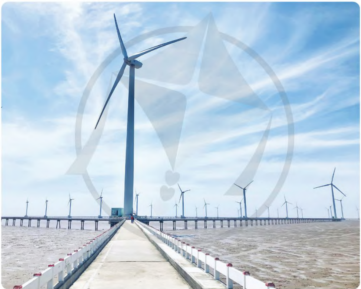
Nhà máy điện gió Bạc Liêu
