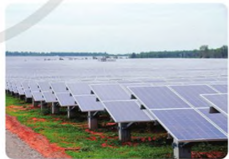
Nhà máy điện mặt trời Bình Thuận
