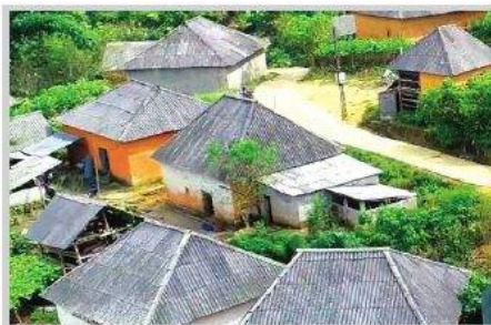
② Nhà trình tường – Nguồn: Thanh Thanh
