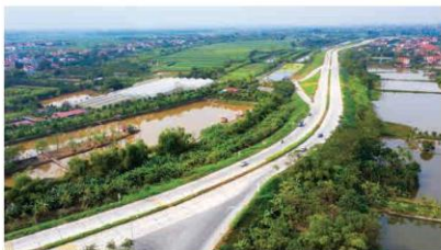
▲ Hình 5. Một đoạn đê sông Hồng
