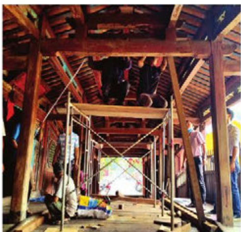
Hình 6. Chèn, chống cột bảo vệ di tích
