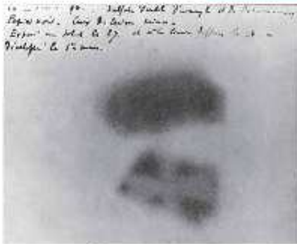
▲ Hình 17.1. Vết đen trên kính ảnh do lọ chứa muối uranium gây ra được Becquerel ghi nhận lại (Nguồn: https://timeline.web.cern.ch/becquerel-discovers-radioactivity/ )
