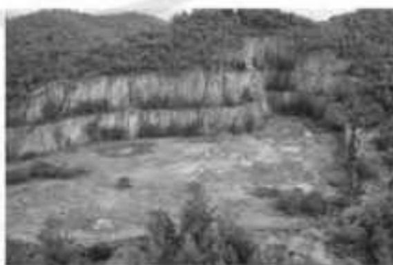
Hình 25.1. Tạo bậc thang để ổn định đất nhằm trồng cây phục hồi rừng tại khu vực khai thác mỏ
