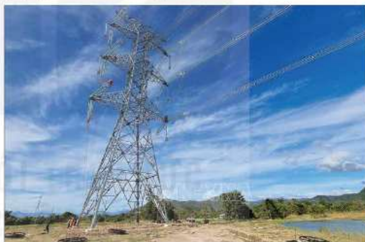
Hình 4. Công trình đường dây điện 500 kV, đoạn qua huyện Bắc Ái (Ninh Thuận)
