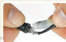
c) Dây điện bị sờn
