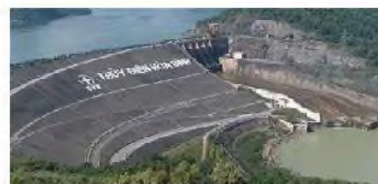
Hình 1.2. Nhà máy thủy điện Hoà Bình
