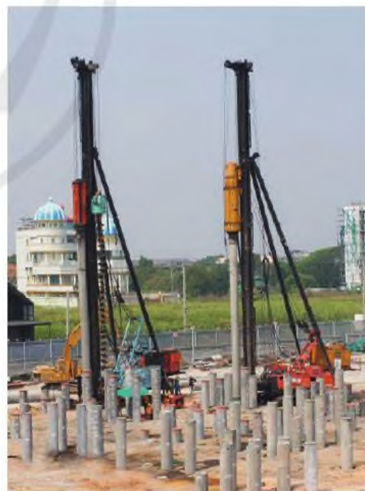
Hình 2.1. Sử dụng búa máy để đóng cọc bê tông
