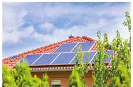
Hình 5. Nhà có sử dụng pin mặt trời
