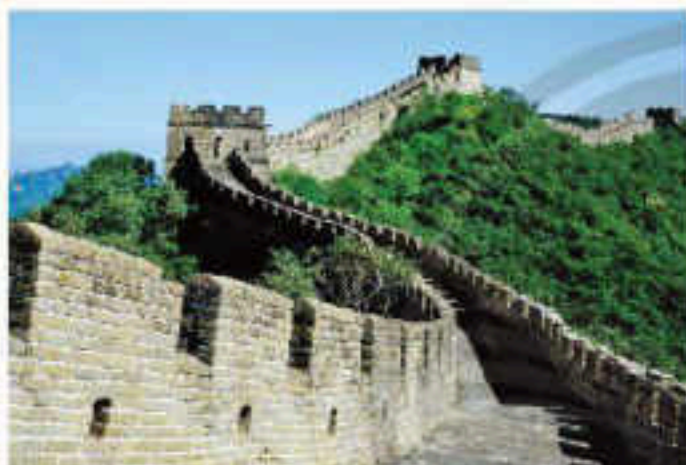
Hình 4.10. Một đoạn Vạn Lý Trường Thành (Trung Quốc)
